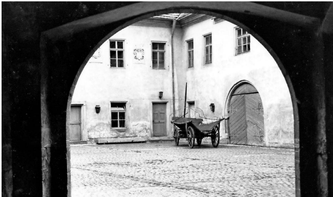
So sah der Innenhof des Deutschordensschlosses vor der Sanierung aus. Vor 25 Jahren fiel der Startschuss. Die Sanierung dauerte bis 2004.
