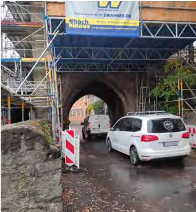
Beengte Zufahrtssituation Jörgentor
