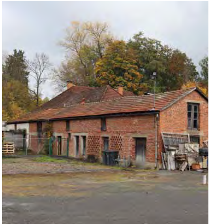
Gebäude mit funktionalen Mängeln
