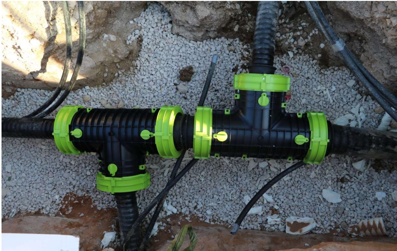
T-Stück im offenen Graben
