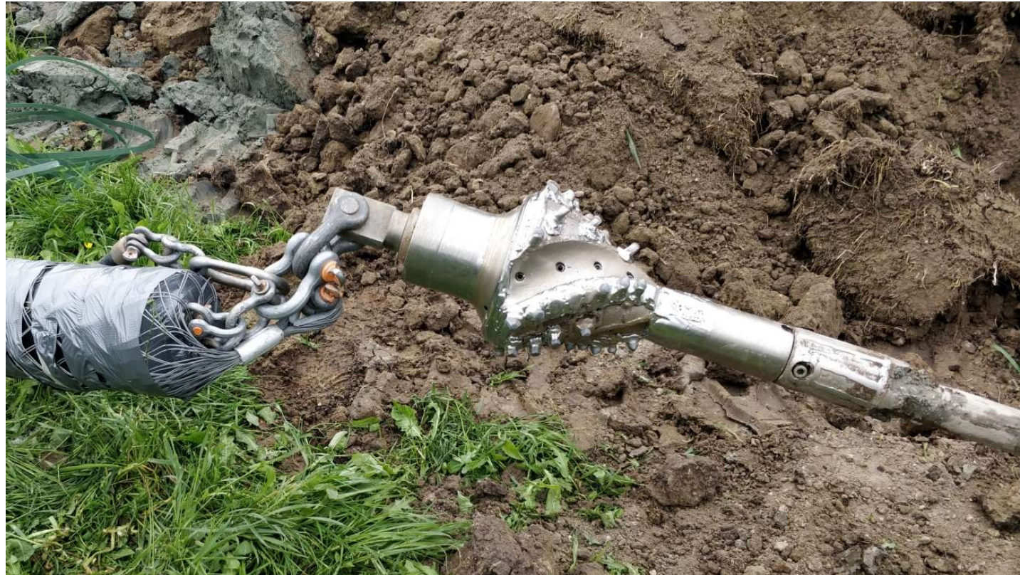
Grabenlose Verlegung im günstigen Spülbohrverfahren
