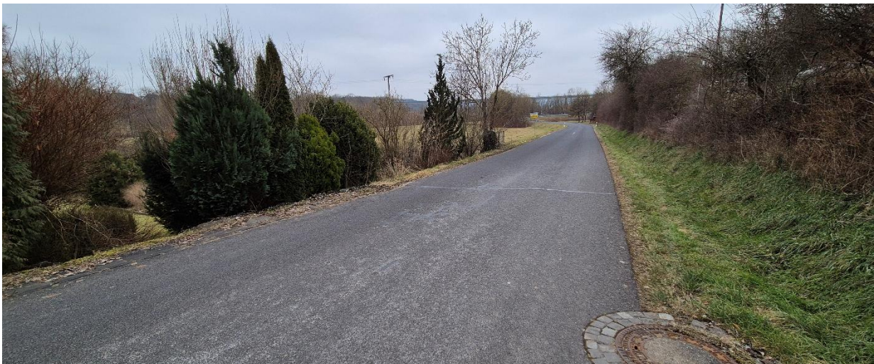
Blick auf Planfläche von Osten
