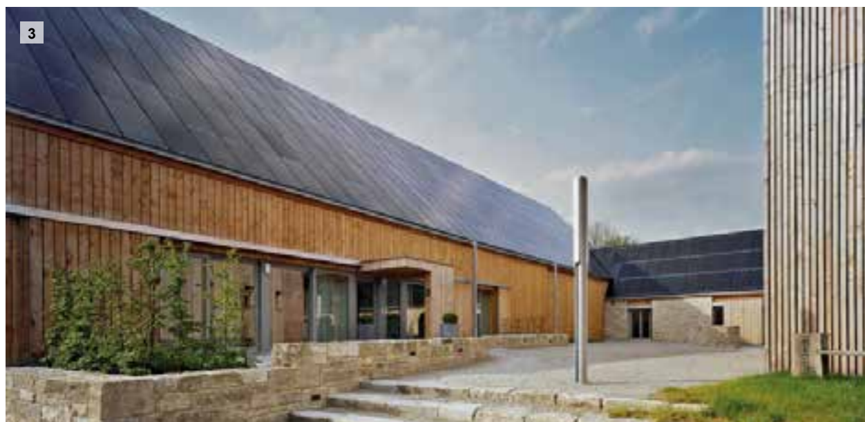
Abb. 3: Positivbeispiel: Hof 8 in Wilersheim: Dachlösung mit Blecheinfassung der Zahnungsfelder (Quelle: DBZ.de, Foto: Brigida González)
