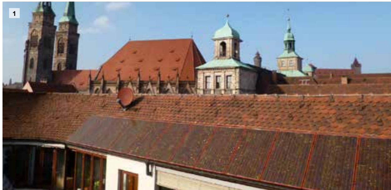
Abb.1: Positivbeispiel: rot getönte PV-Anlage auf Nürnberger Rathaus (Quelle: Deutsche Stiftung Denkmalschutz, Foto: Stadt Nürnberg)
