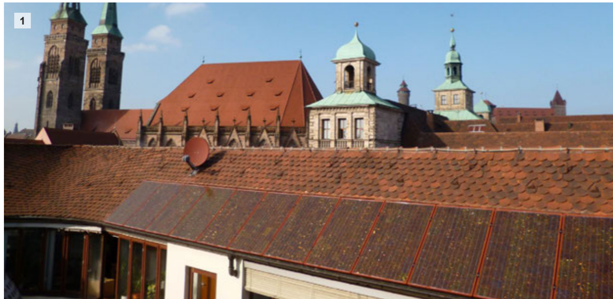
Abb.1: Positivbeispiel: rot getönte PV-Anlage auf Nürnberger Rathaus (Quelle: Deutsche Stiftung Denkmalschutzafie, Foto: Stadt Nürnberg)
