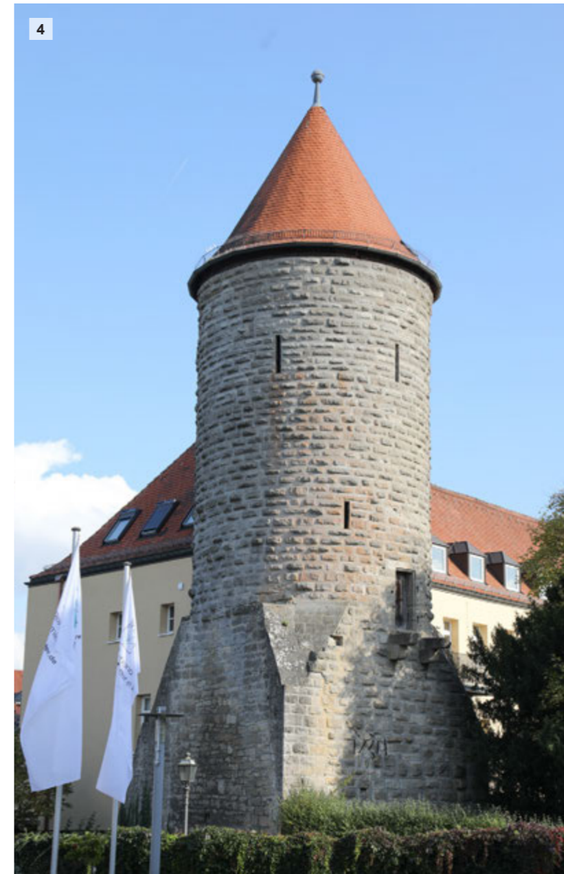
Abb. 1 Jörgentor und historische Stadtmauer am Leitschuhweg (Foto: Andreas Poost)
