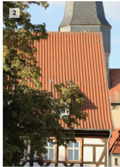
Eindeckung mit Falz - Hohlfalzziegel (Abb. 2) - Doppelmuldenfalzziegel
