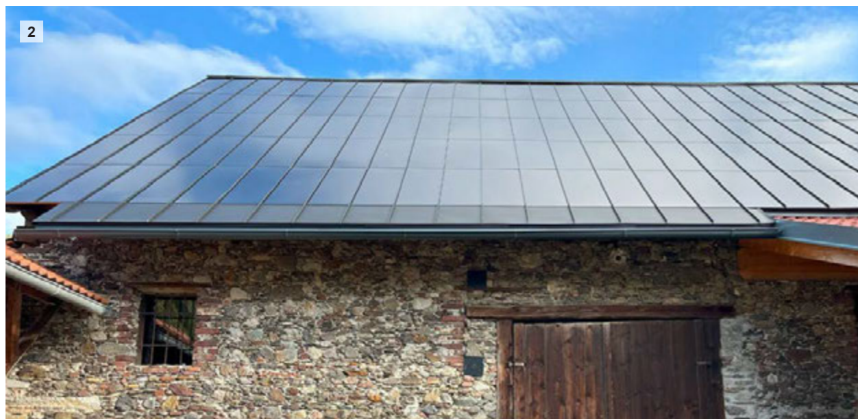
Abb. 2: Positivbeispiel: Scheune mit, in Stehfalzdeckung integrierter Photovoltaikanlage und Traufverblechung im Modulmaß (Quelle: Haushut.com)
