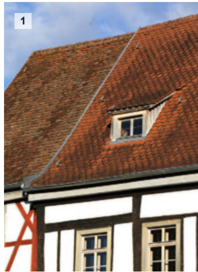
Historische Eindeckung - Bieberschwanz (Abb. 1) - Hohlpfanne
