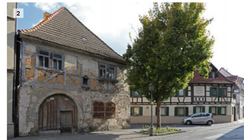
Abb. 1 Gelungene Sanierung und Bestandserhalt: ortstypisches Tor und Scheune in Malergasse (Foto: Andreas Poost)
