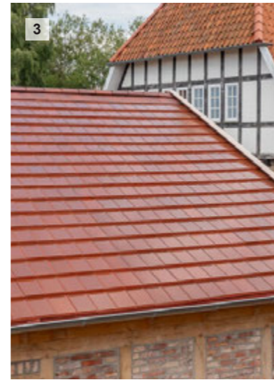
Moderne Tondachziegel - gradliniger Glattziegel (Abb.3) - schlechteres Abtropfverhalten
